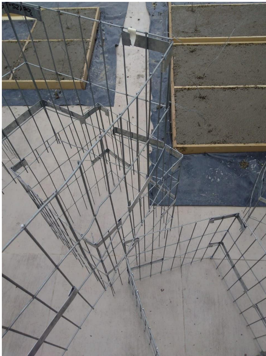
(imagen 7) Gaviones y tapas prefabricadas de hormigón.
