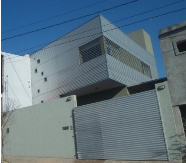
Figura 1 - casa Dumas 2060. Revestimiento ventilado Durán - Barraud arquitectura.
